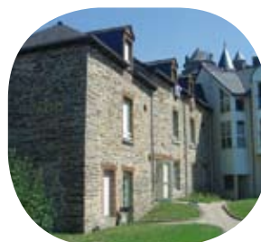
Châteaugiron SA Les Foyers
